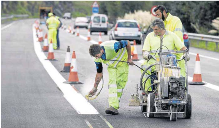
Los carriles centrales de aceleración se han eliminado en varios tramos de la N-629. :: ROBERTO RUIZ
