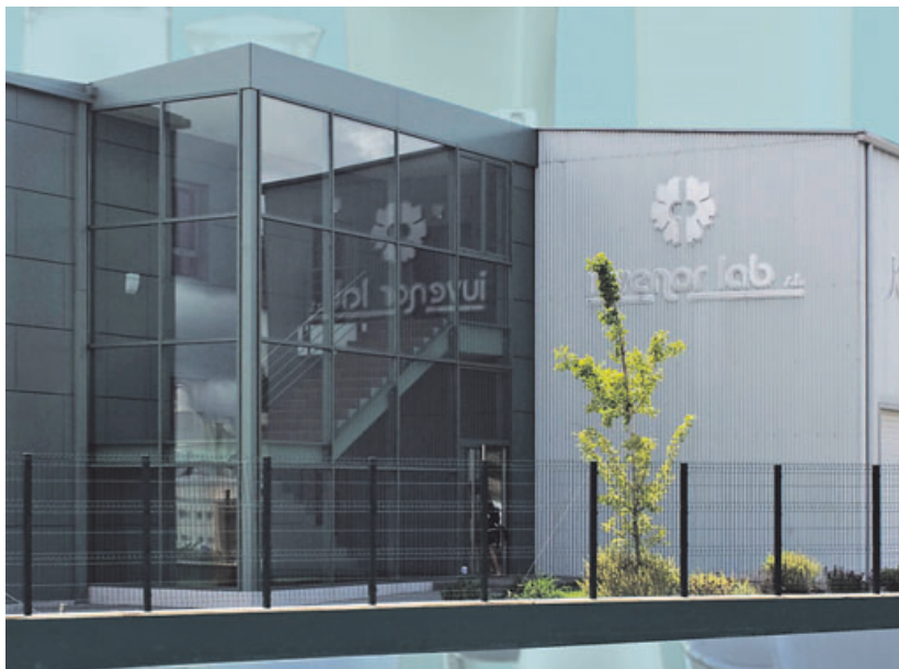
Fachada principal de la sede de la compañía, en la villa ourensana de O Carballiño
