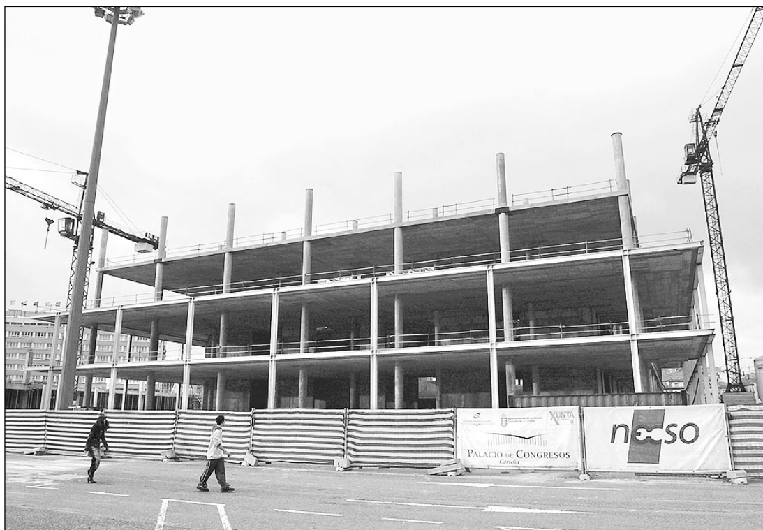
Las obras del nuevo Palacio de Congresos cumplen los plazos de ejecución previstos / Pedro Puig
